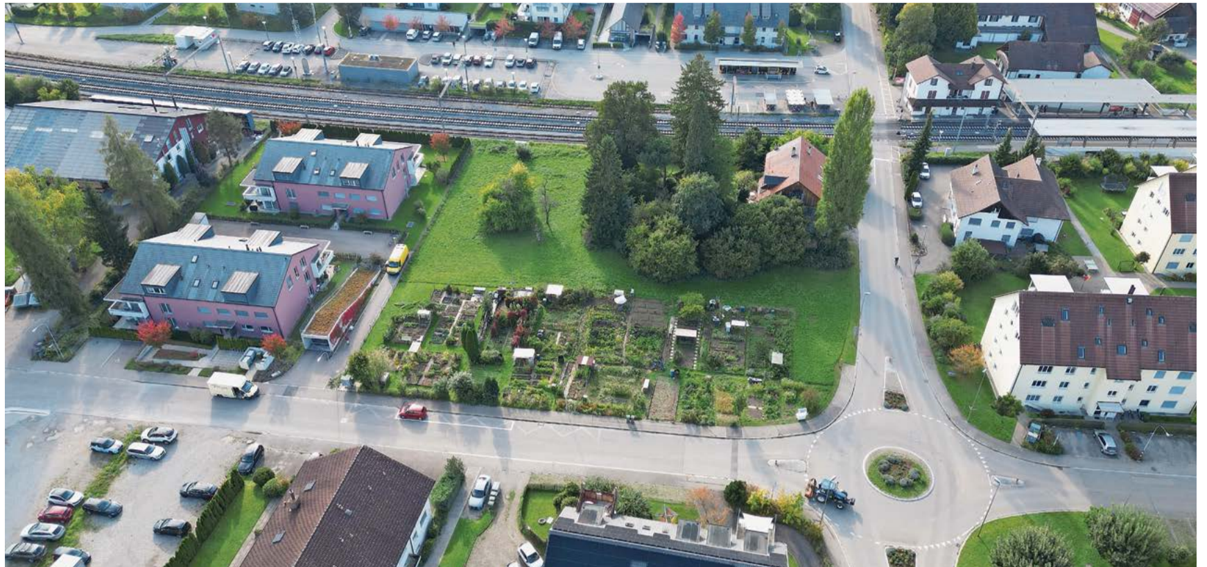
Die Parzelle 1552 (Bildmitte) ist von der Gemeinde zur Investorensuche ausgeschrieben worden. Daraufhin gründete und bewarb sich die Genossenschaft Hegewo, die günstigen Wohnraum für alle Generationen bieten will. Bild: Archiv
